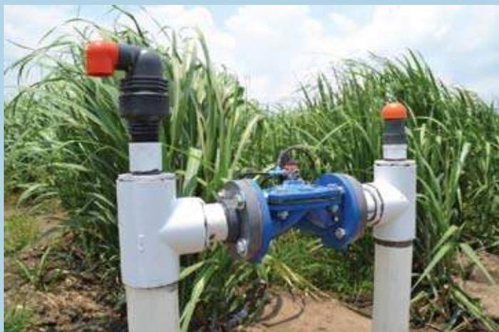
Воздушные клапаны играют важную роль в обеспечении эффективной и надежной работы системы орошения.
