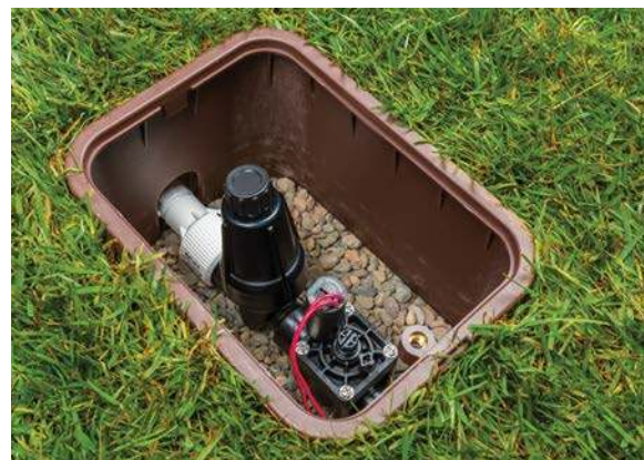
Пример установки PCZ-101 в универсальном корпусе
