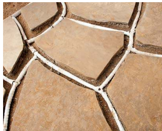
Пример установки Eco-Wrap
